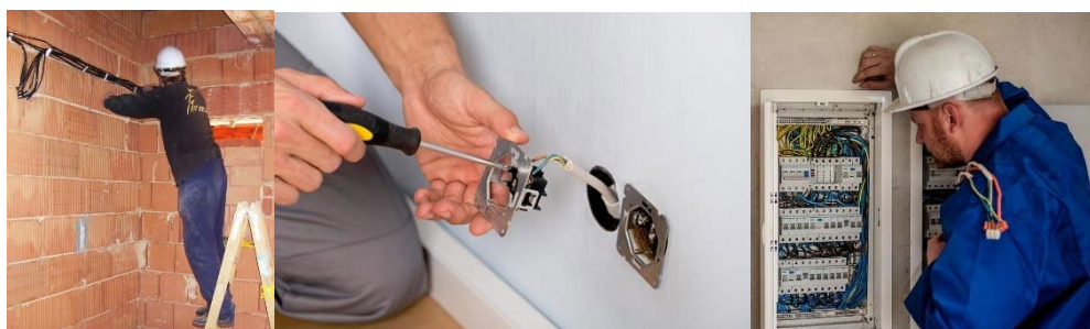
Obr. 35: Zleva: Instalace kabeláže do zdi, montáž síťové zásuvky, zapojení elektrického rozvaděče [24].
