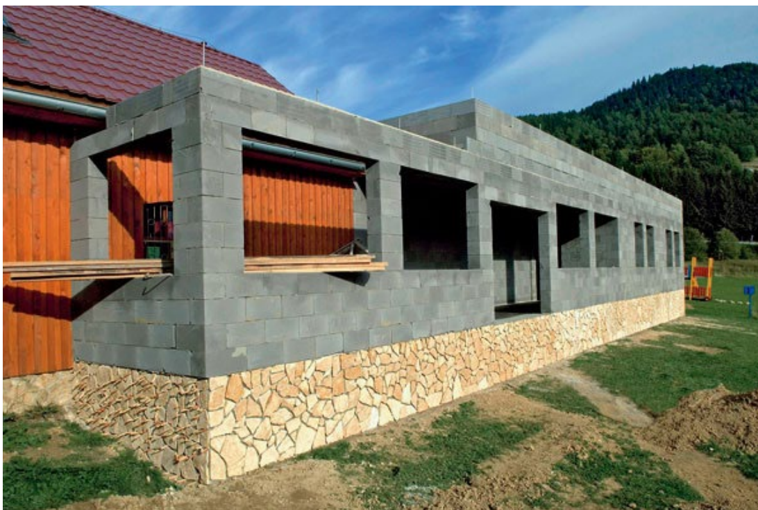
Obrázek 14: Obvodová zeď z pórobetonových tvárnic [11].
