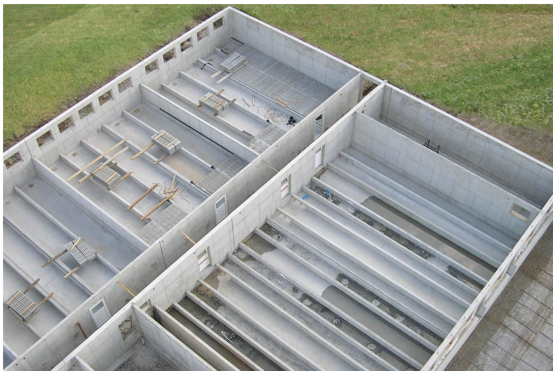
Obrázek 17: Obvodové zdi z velkoplošných stěnových systémů [14].
