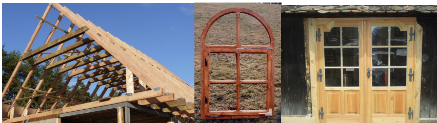
Obr. 36: Zleva: Vazníkový krov, tesařský rám okna, vchodové dveře z masivu [25].
