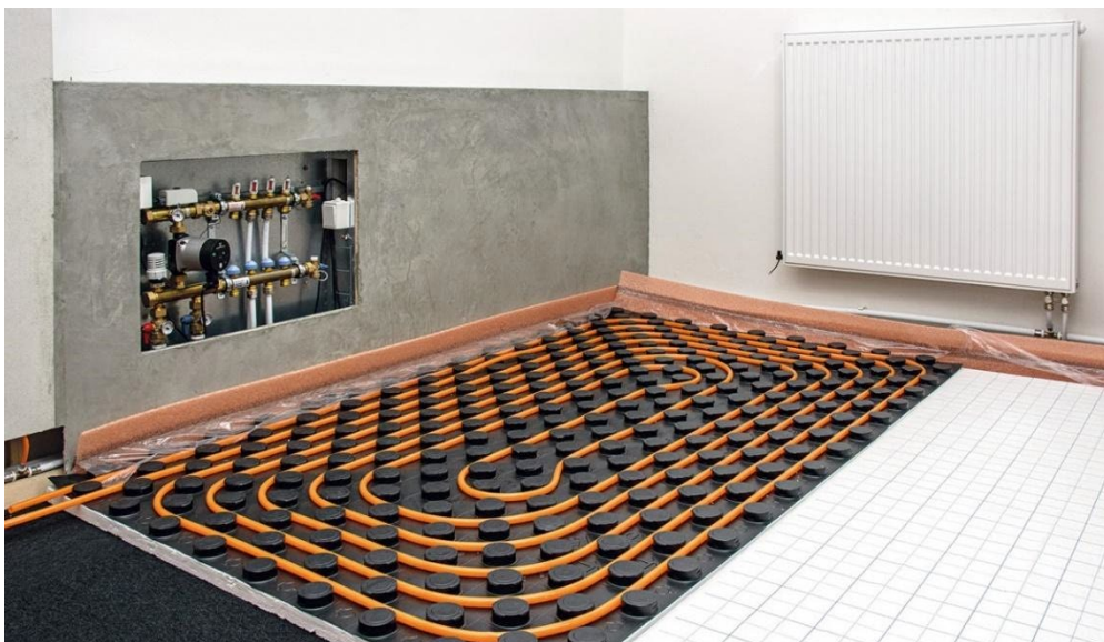
Obr.44: Princip podlahového vytápění (zdroj: archiv Miroslava Rosmanita).
