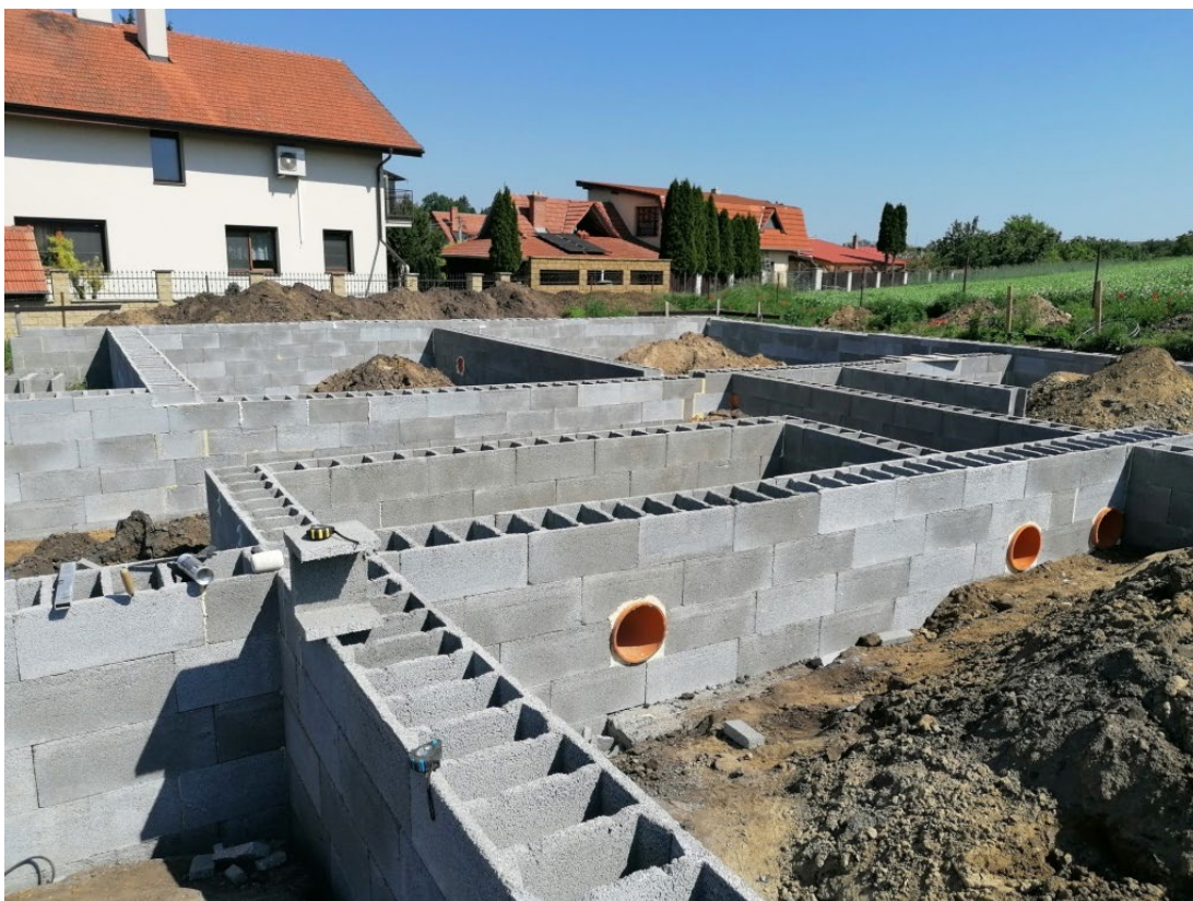
Obrázek 16: Základy rodinného domu v Hovoranech z IZOBETONU [13].
