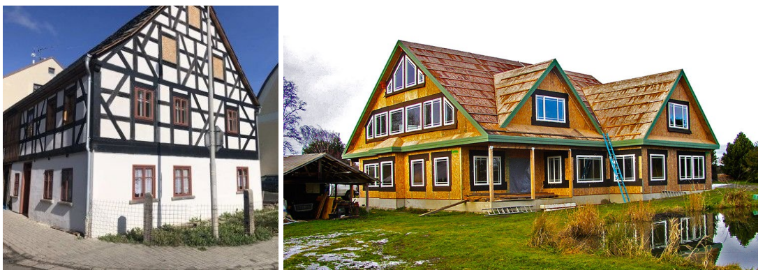
Obr. 19: Hrázděnka a sendvičová stavba [17, 18].
