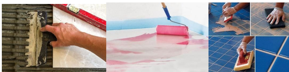
Obr. 34: Zleva: vyrovnání podkladu, penetrování, spárování dlažby [23].
