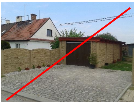
Obrázek 9: Nesprávně dodržena vzdálenost stavby garáže od sousedovy parcely (zdroj: archiv Tomáše Čecha).
