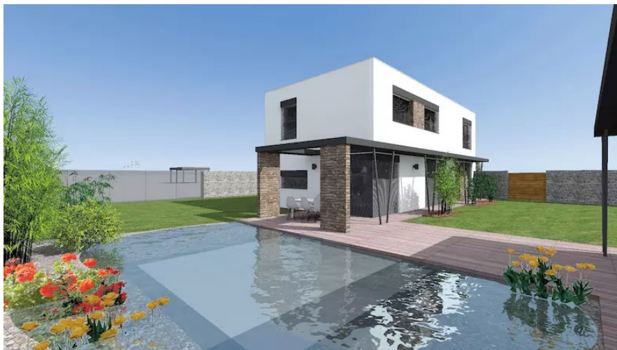
Obr. 51: Nízkoenergetický dům se vyznačuje jednoduchým tvarem, důkladnou tepelnou izolací a kvalitními velkoformátovým prosklenými prvky (zdroj: archiv Miroslava Rosmanita).
